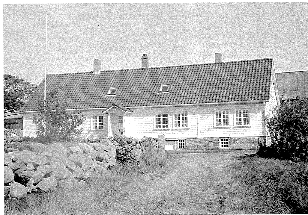
Bolighus, Vik. Eksempel på det såkalte utvidete jærhus. Eldste delen fra siste del av 1600-tallet. Huset fikk sin nåværende form på slutten av 1800-tallet. Etter fullstendig restaurering i tråd med de antikvariske retningslinjer ble eierne tildelt Klepp kommunes arkitekturvernpris for 1994.
