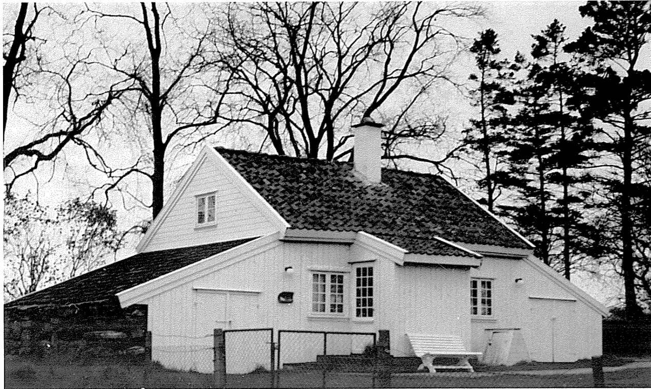
Lite jærhus med to skuter, Håland. Fra slutten av 1800-tallet. Nå i kommunens eie. Et eksempel på heldig bruksendring. Etter at huset i 1993 var ferdig restaurert ble det tatt i bruk som utstillings og utsalgslokale for lokale brukskunstnere.
