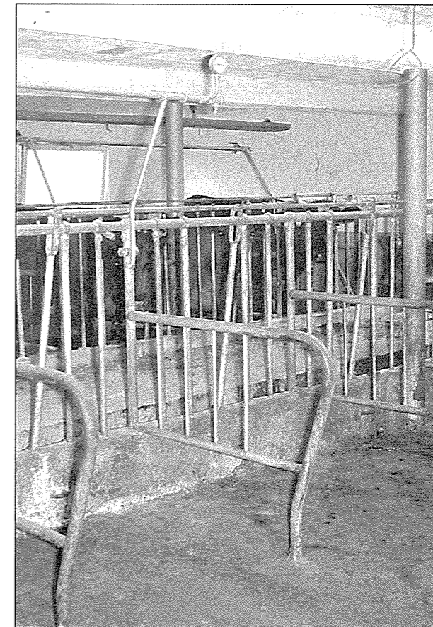
Interiør frå fjøset på Revheim. Innreiinga er fabrikkprodusert langbås. Her er det høge forbrettet kome att.
