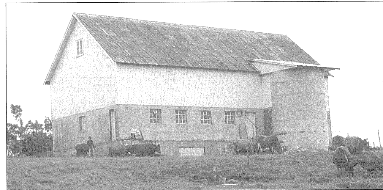
Løa på Goa. Asbest- sement bølge- plater er nå vanlegaste taktekkings- materialet. Siloen er komen på utsida.
