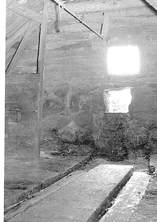
Til venstre: Interiør frå fjøset på Fosse. Under vindauget, som opphavelag nok ikkje har vore der, ser ein moksteholet. Under gangen mellom gjødsel-rennene er det ein landkum.
