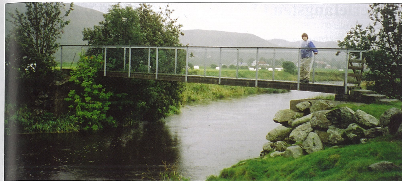
Roger Risa er på veg over "Planken" – ein regnvêrsdag i september 2004. Det var ein gong ei bru over åa her som fekk avløysing av denne "planken" - ei gangbru - i betong mellom Taksdal og Litla Undheim. Foto: H.T. Indrebø.
