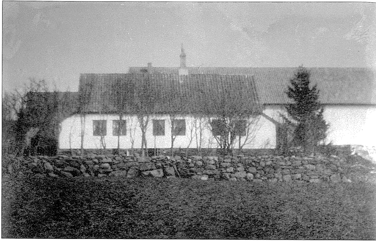
Tunet på Mauland omlag 1920. Huset er frå 1845, løa er bygd 1911/1912, *Torkel Mauland.
