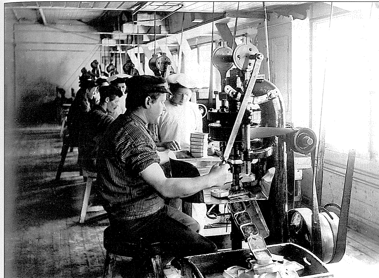
Reinerts falsemaskin i bruk i ein av Chr. Bjelland sine fabrikkar i Stavanger kring 1905. Foto: *Stavanger Museum.
